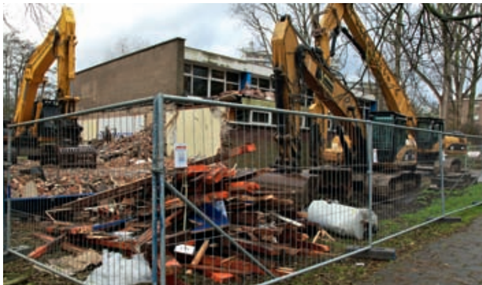
Sloop van oude schoolgebouw
